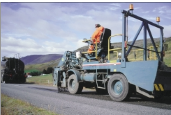
Malarútlögn með eldri gerð af malardreifara fór þannig fram að vörubílinn bakkadi með dreifarann og sturtadi efninu jafnóðum. Bílstjórinn hafði því um margt að hugsa. Sjálfkeyrandi dreifari dregur vörubílinn á eftir sér og bílstjórinn þarf bara að sturta efninu. Stjórnandi dreifarans sér um að stýra efninu í bindiefnið.
