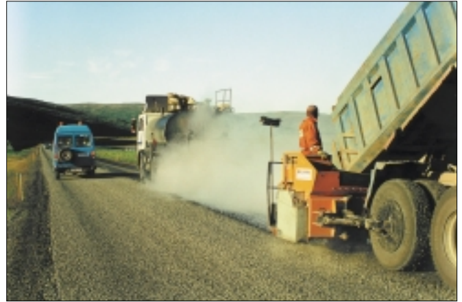
Eldri gerð af malardreifara. Tveir starfsmenn standa á dreifaranum og moka efninu til ef á þarf að halda. Þeir sjá líka um að festa dreifarann við vörubílinn og losa hann aftur. Við útlögn myndast reykur frá heitu asfalti og berst hann yfir starfsmenn á malardreifaranum.
